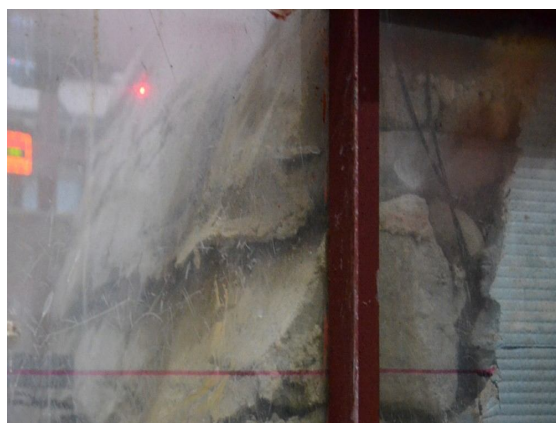
(b) 坡体中上部出现大幅度层间错动
