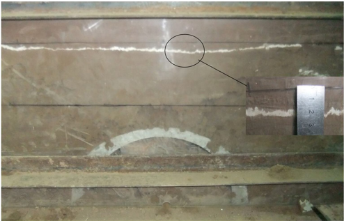
图 7 明洞顶平面沉降变形图
