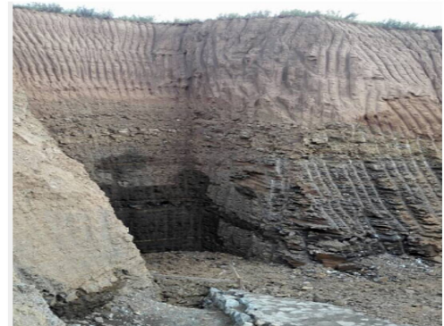
图 4 涵洞南侧出口岩层渗水
