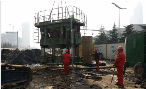
图 1 全套管灌注桩 Fig. 1 Benoto Pile
