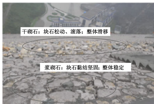
图 2 两种砌石护坡的震后状态对比
