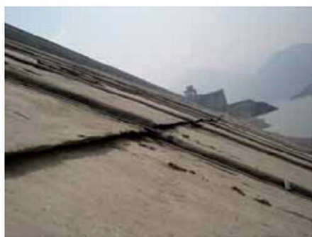
(a) 845 m 高程施工缝剪切破坏
