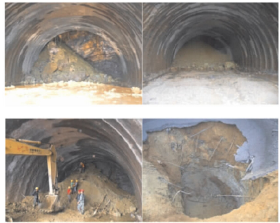
图 2 隧道掌子面破坏实例 [19]
