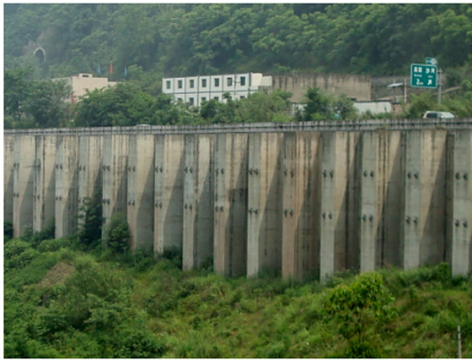
图 1 预应力锚索桩板墙
