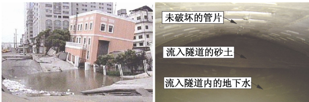
(b) 地面塌陷、建筑物倾斜 (c) 流失到隧道内大量的水和泥沙
