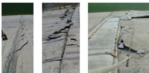
图 1 天生桥一级面板坝的面板挤压破坏形态
