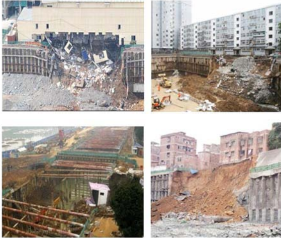
图3 基坑在长度方向上的连续破坏和终止案例
