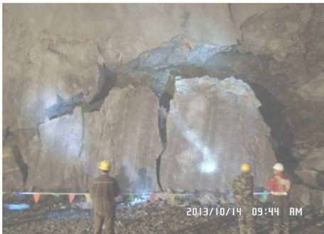
图 8 主洞室⑧岩体失稳现场情况图 Fig. 8 Rock mass collapse in cavern No. 8
