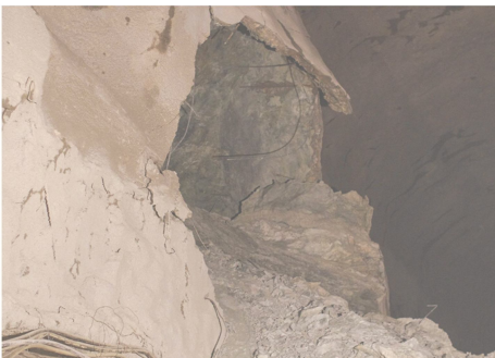
图 7 主洞室⑤岩体失稳现场情况图 Fig. 7 Rock mass collapse in cavern No. 5
