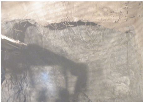
图 6 主洞室③岩体失稳现场情况图 Fig. 6 Rock mass collapse in cavern No. 3
