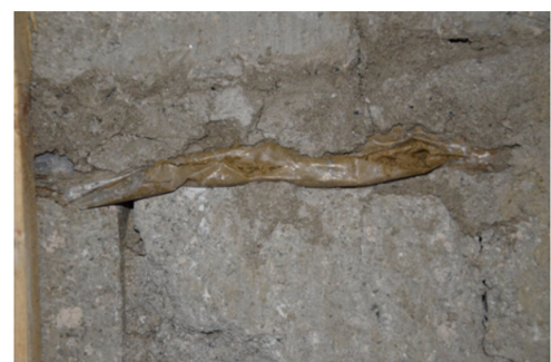
(b) 坡体中部泥化夹层被挤出
