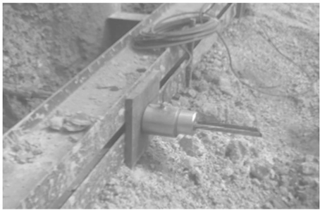
图 4 监测仪器安装大样
