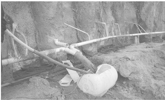
图 4 有组织引流排水系统 Fig. 4 Organized drainage system
