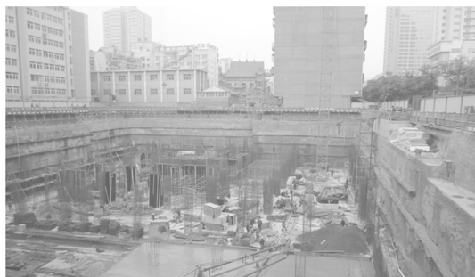
图 3 基坑支护照片
