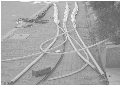
图 2 制作完成后的浆囊袋压力型土钉 Fig. 2 Produced slurry pocket pressure type soil-nailing
