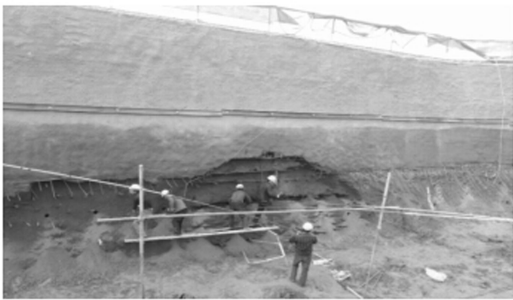
图 2 坡底部分土体坍塌
