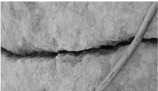
图 1 坡顶附近土体开裂
