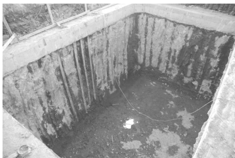
图 4 基坑开挖现场图
