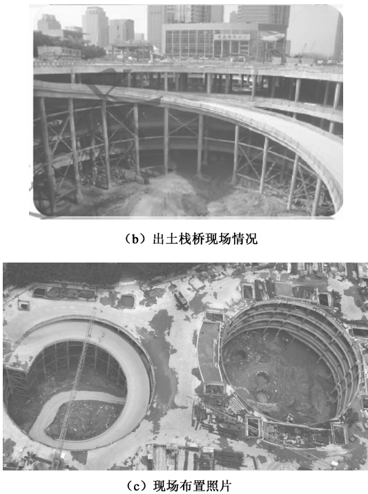
图 11 基坑出土栈桥示意图及现场照片 Fig. 11 Trestle and photos of foundation pit
