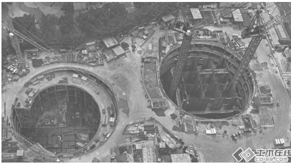
图 4 双圆环支撑现场照片
