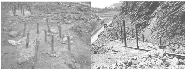
图 1 微型桩群加固边坡工程实例
