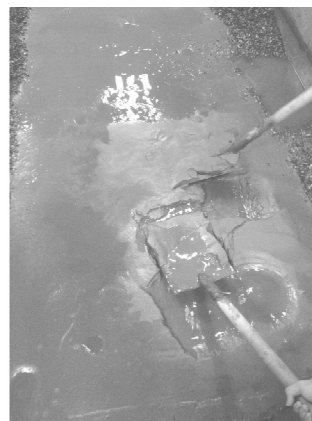
图 3 卸载后基础层状况
