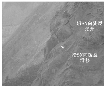
(b) 小湾水电站右岸某边坡浅表层阶梯状滑面
