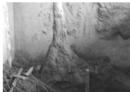
图 16 袖阀管桩的底部
